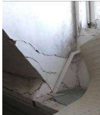
Fotografia 1 – Zona junto ao telhado com infiltração de humidade e janela antiga e deteriorada sem capacidade de isolamento.
